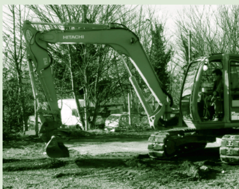
The first dig
